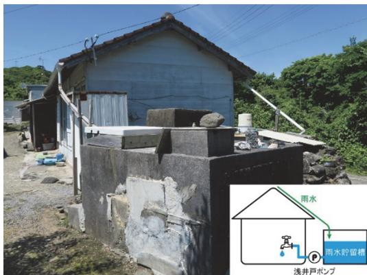
図2 赤島島内の雨水貯留槽写真と構成
