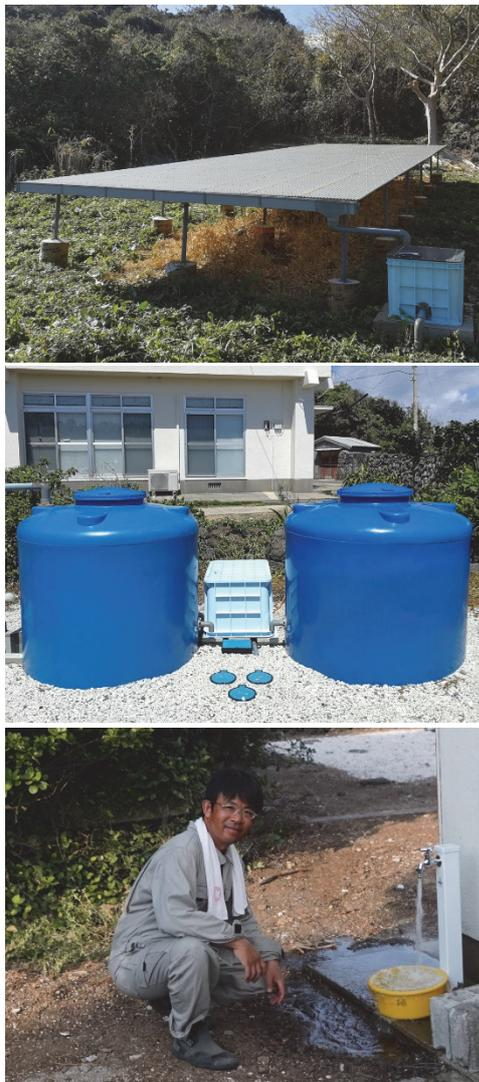
図5 雨水を水源とした給水システム(2019/10)
